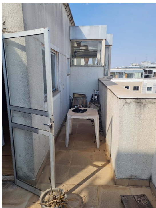
Área externa (piso superior)
