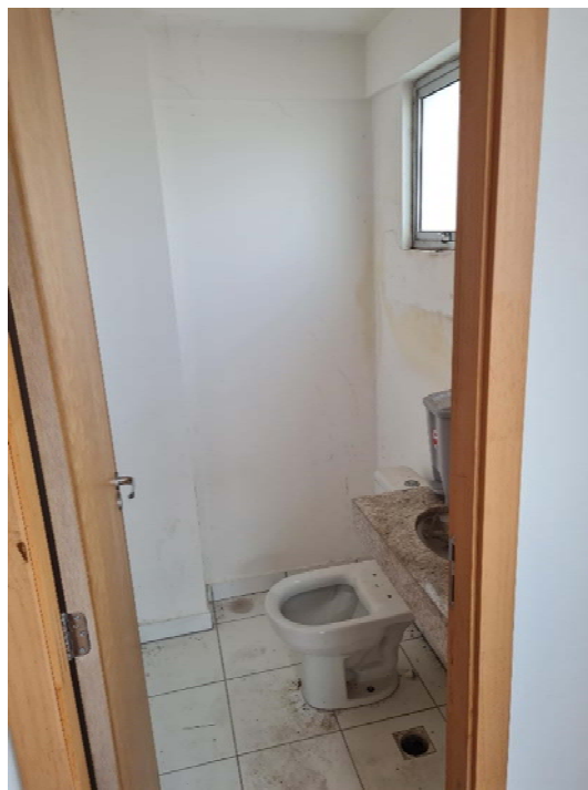
Banheiro (piso superior)
