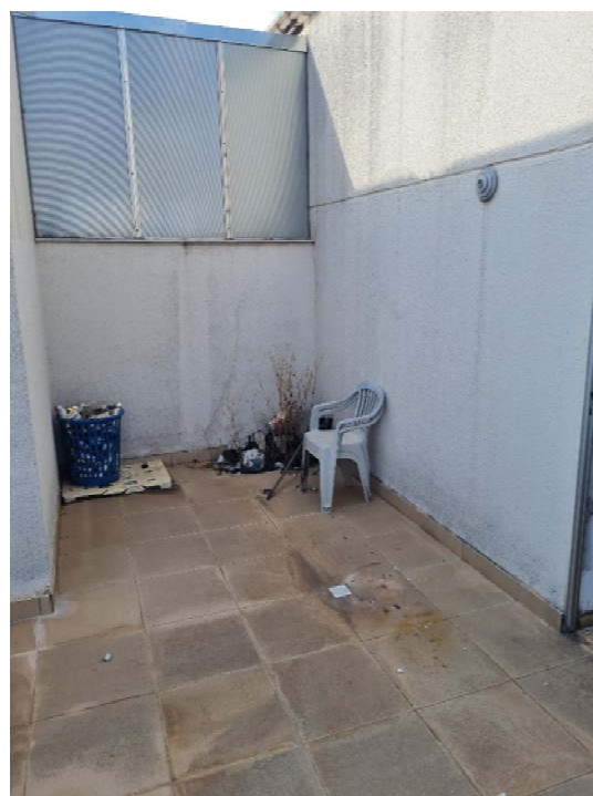
Área externa (piso superior)
