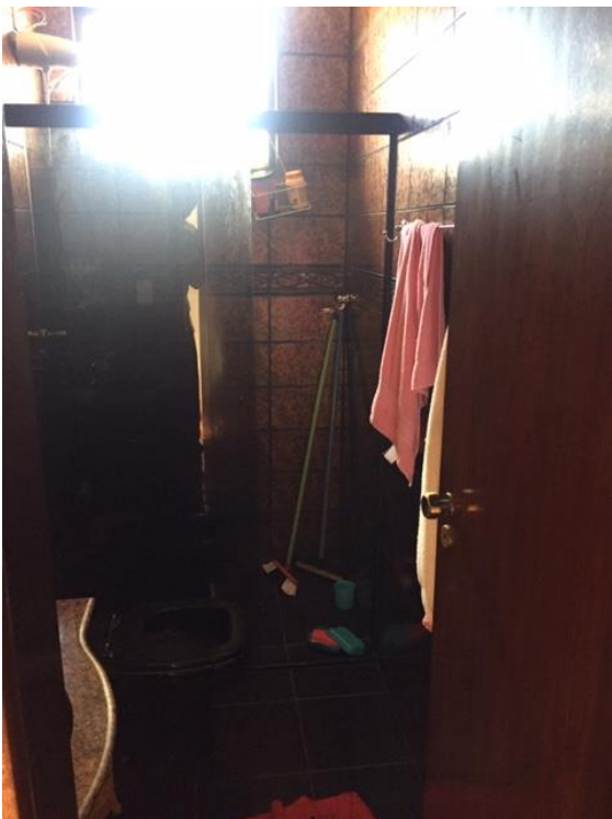
Banheiro (andar superior)
